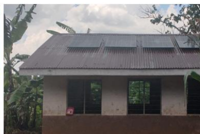
Solceller til drift av pumpe
