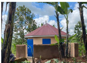
Ny latrine med 8 seter på plass
